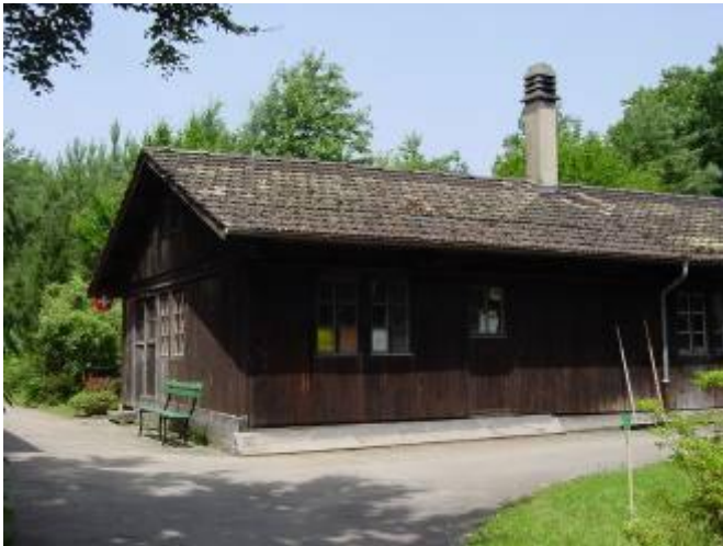
Werkstatt (ehemalige Rot-Kreuz-Baracke, 2. Weltkrieg), Abbruch und Ersatzbau
