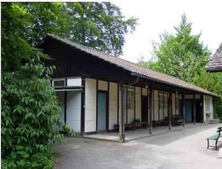
Sozialräume (ehemalige Garderobenbaracke vom Eisweiher am Spitzwiesenbach) werden in Sarglager umfunktioniert
