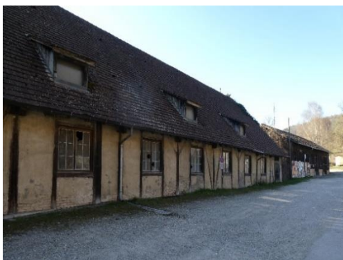
Ansicht strassenseitig, Abbruch
